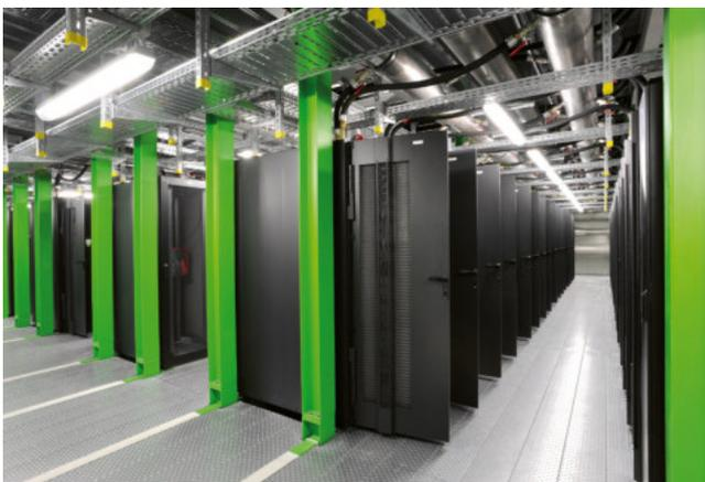
Rackreihen mit darüber liegender Kühlwasserverrohrung
